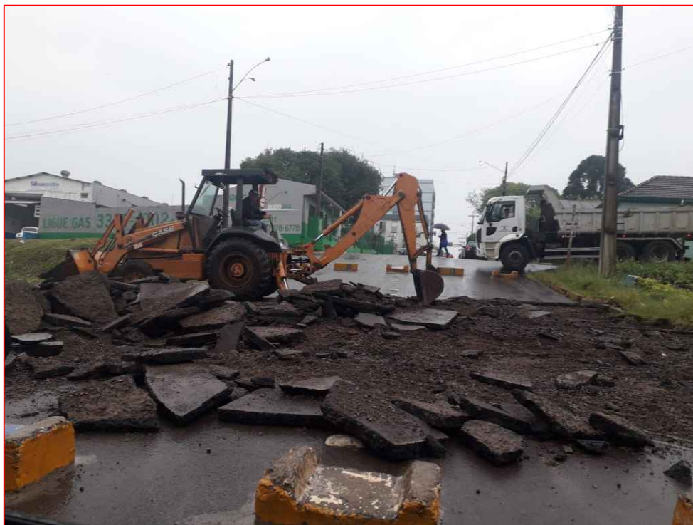
Demolição de Pavimentação Asfáltica
