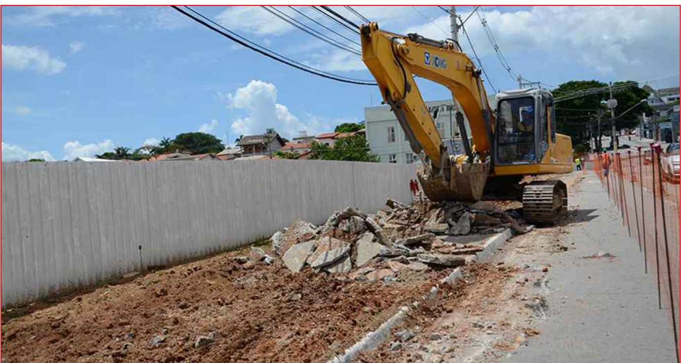
Remoção de Pavimento Intertravado "Paver"
